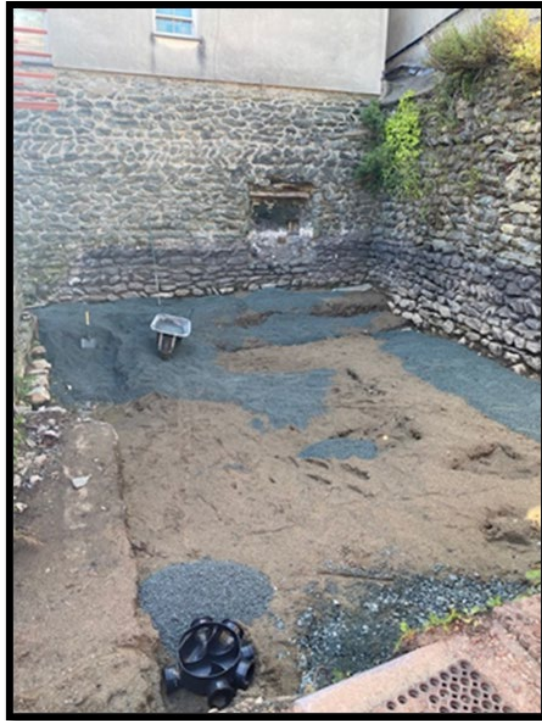
Paratoi sylfeini Eglwys y Bedd Preparation of footings
